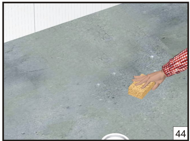
44 Nettoyez le fond du bassin ainsi que les murs intérieur. Grattez ou rebouchez les imperfections si besoin.
